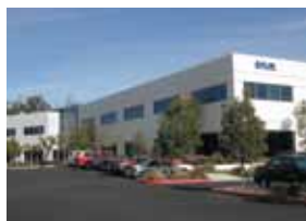
FLIR Santa Barbara
